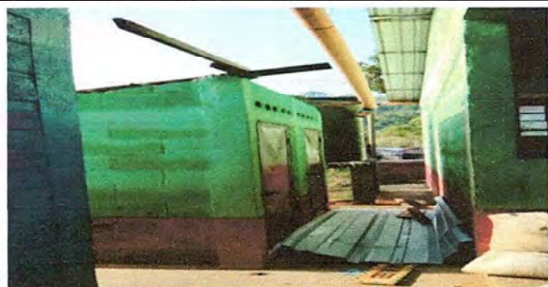
Foto 3: Desmontaje de techo de los baños.
