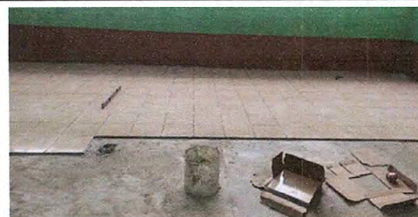
Foto 6: Colocación de piso cerámico en un aula.
