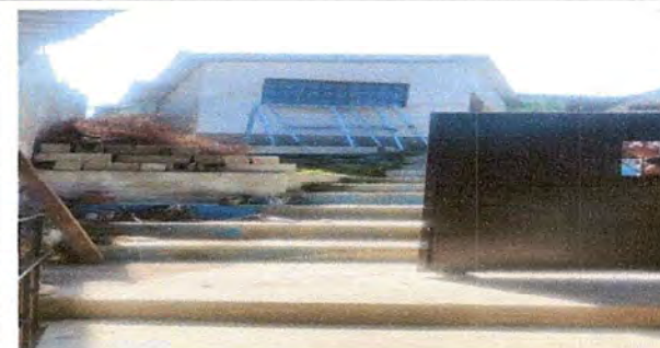
Foto 4: Colocación de portón.
