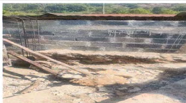
Foto 2: Cimiento para muro de block parte de enfrente.
