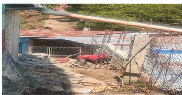
Foto 1: Início del muro perimetral de block Parte de enfrente
